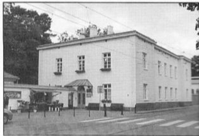
Siedziba Zarządu przy ul. Rakowickiej 26.
